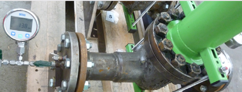
Dichtheitsprüfung unter Realgas
