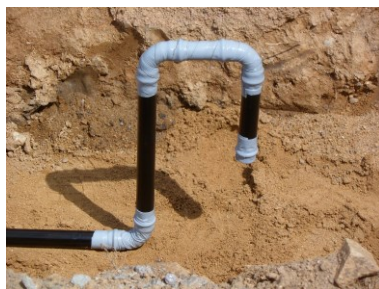
Abbildung 8: Verlauf der Gasleitungen und Ausströmöffnung
