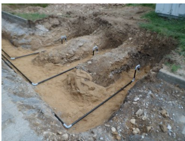
Abbildung 8: Verlauf der Gasleitungen und Ausströmöffnung
