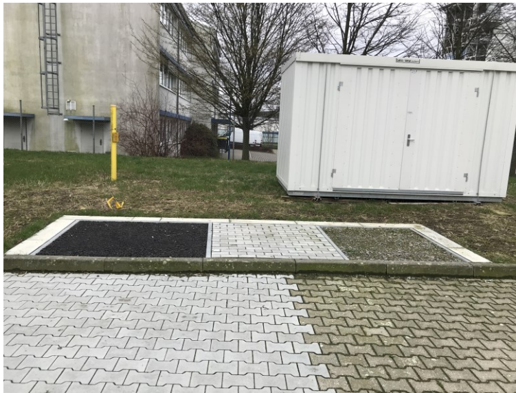
Abbildung 7: Spürflächen an der Baggerschaden-Demonstrationsanlage (BSDA) des Trainingszentrums Gas am DBI – Gastechnologisches Institut gGmbH Freiberg
