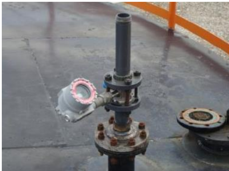
Abbildung 4: Turbinenmessgerät [16, S. 20]
